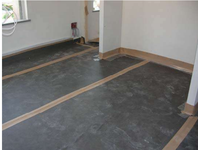
Detalle de instalación de lámina de PE reticulado en suelo flotante
