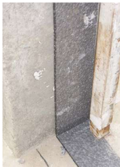
Colocación de banda de EEPS en perímetro de fábrica
