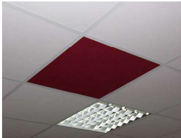
Detalle de un techo acústico con lana de poliéster
