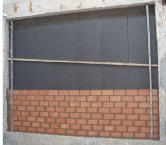
Detalle de la instalación de EEPS en trasdosados directos y cámaras de aire
