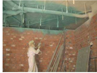
Detalle proyección de espuma de poliuretano de celda abierta en soluciones horizontales
