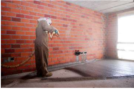
Detalle proyección de espuma de poliuretano de celda abierta en soluciones horizontales
