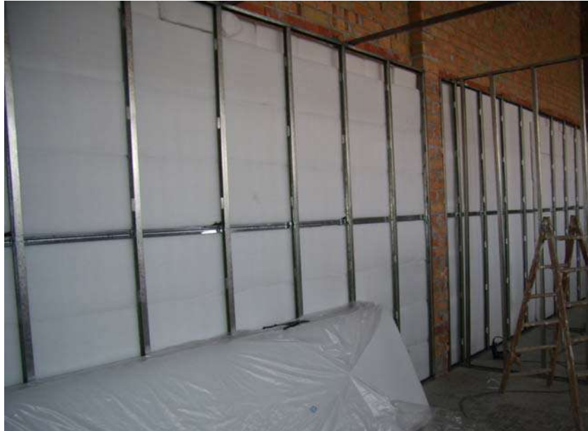
Detalle de la instalación de lana de poliéster en un entramado autoportante de placa de yeso laminado
