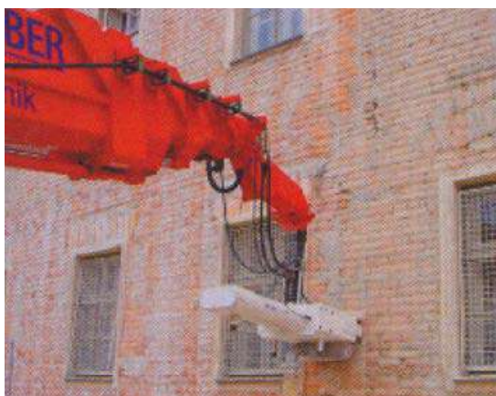
Foto: Fresa en funcionamiento
