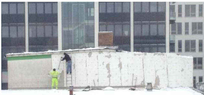
Fotos: Deconstrucción de un SATE
